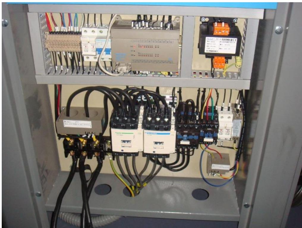
Блок серого цвета- система автоматической проверки системы PLC
